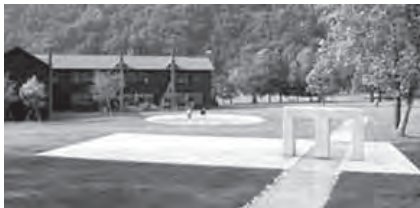
木造二階建ての小学校舎と広場
